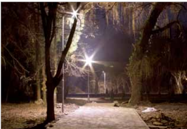
Abb. 3: Beleuchtung von Wegen
